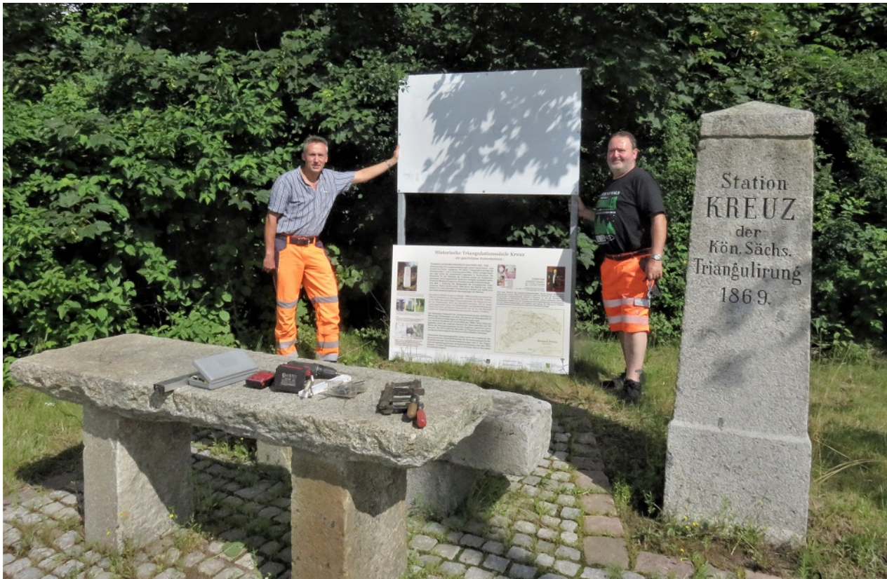
Montage der neuen Informationstafel für die Station 100-Kreuz am 12. Juli 2021
